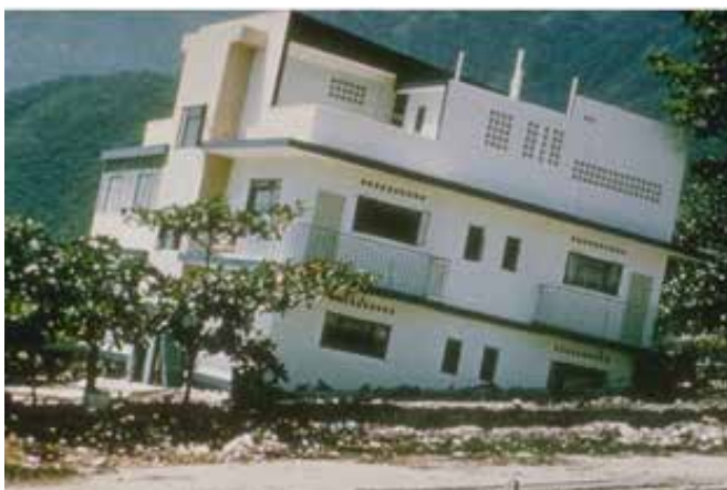
Σχήμα 1: Μεγάλες διαφορικές καθιζήσεις λόγω ρευστοποίησης σε κτίριο (χωρίς εμφανείς δομικές βλάβες) κατά το σεισμό του Caracas Venezuela 1967 ( M=6.5 ).
